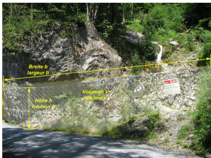
Fig. 10 : exemple d'ouvrage de retenue pour les laves torrentielles (filet)
