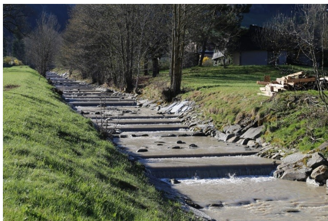
Fig. 19 : petits seuils en escalier (exemple du Steiglebach, commune de Marbach, LU) : à gauche, photo, à droite, plan de situation. (sources: Kanton Luzern, DS Verkehr und Infrastruktur (vif), Abt. Naturgefahren; Office fédéral de la topographie swisstopo: géoportail fédéral)
