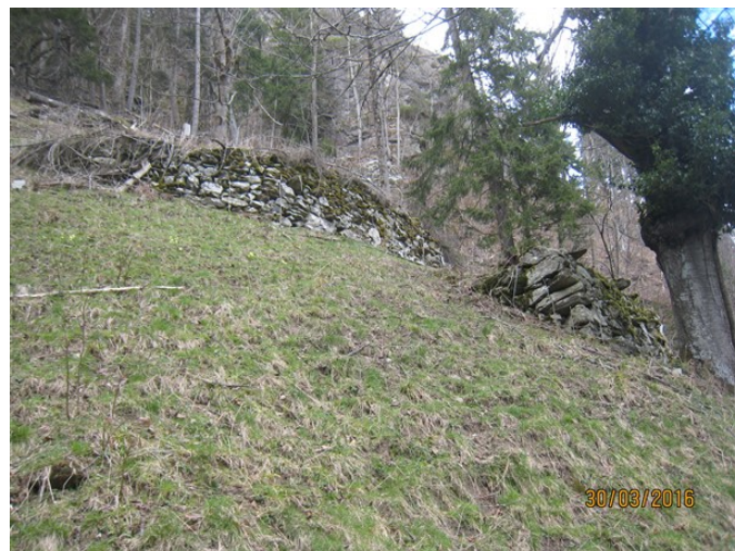
Fig. 20: ouvrages de stabilisation de la pente des CFF datant des années 1900 : à gauche, groupe d'ouvrage, à droite, ouvrage isolé. (source : SBB AG : Ingenieurbau und Umwelt, Natur und Naturrisiken)
